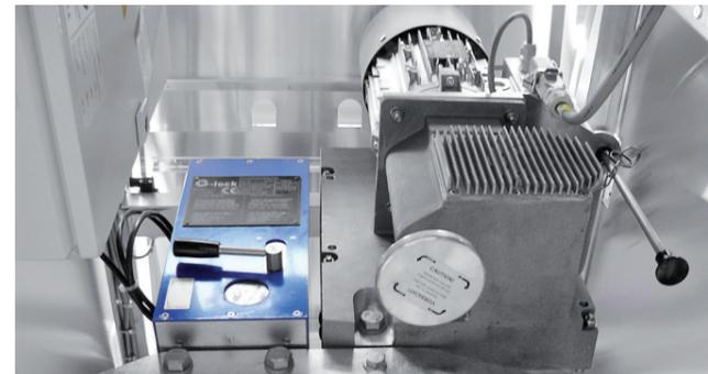
Das Herzstück des G-servicelift® bilden die G-trac® und der G-lock® von goracon. In den Klassen 400kg – 1000kg für Personenbeförderung erhältlich, begeistern die G-trac® und der G-lock® durch Qualität „Made in Germany“. Die zuverlässige und leise Laufeigenschaft der Personenwinde kombiniert mit dem präzisen Auslösemechanismus der Fangvorrichtung befördern ihr Personal im G-servicelift® sicher in die Höhe.
